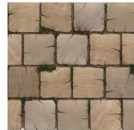
Opskårede spær som stolpegulv
