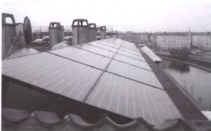
Solcellepaneler med 15 graders hældning. Foto: Klaus Boyer, Solarvent ApS
