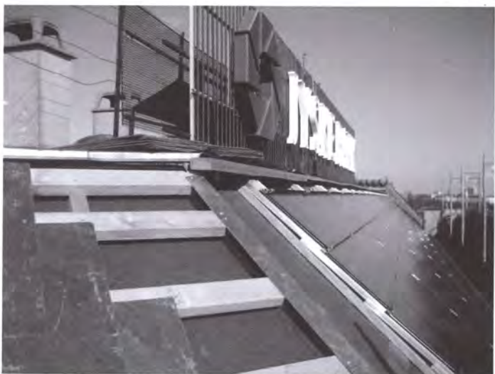
Solcellepaneler med 15 graders hældning. Foto: Klaus Boyer, Solarvent ApS
